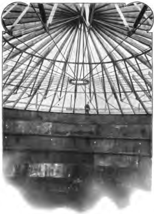
Внутренній видъ резервуара.
