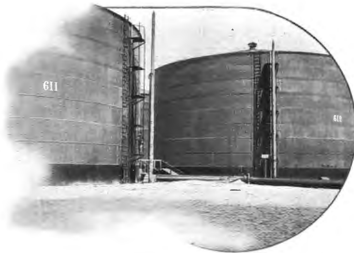
Резервуары для нефти.
