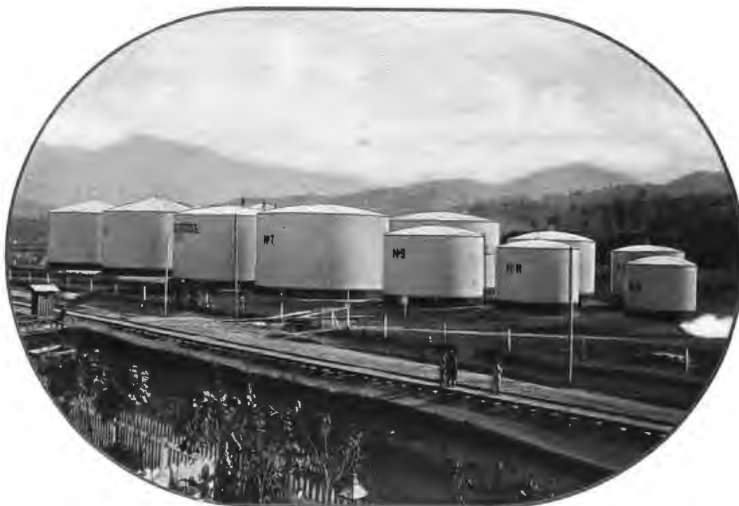
Резервуары Товарищества въ Батумѣ.
