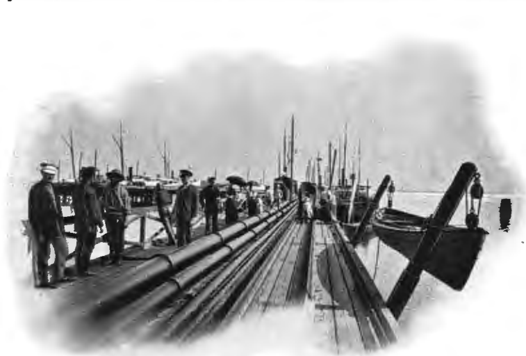
Трубопроводы на наливной пристани Т-ва.
