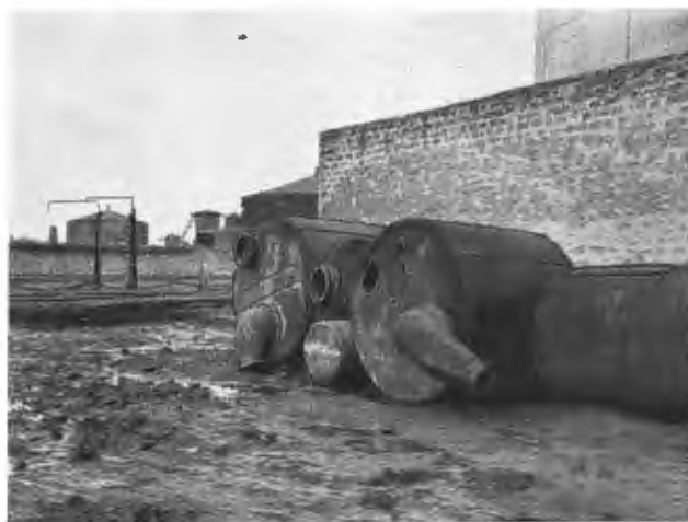
Перегонные кубы первоначальной конструкціи.
