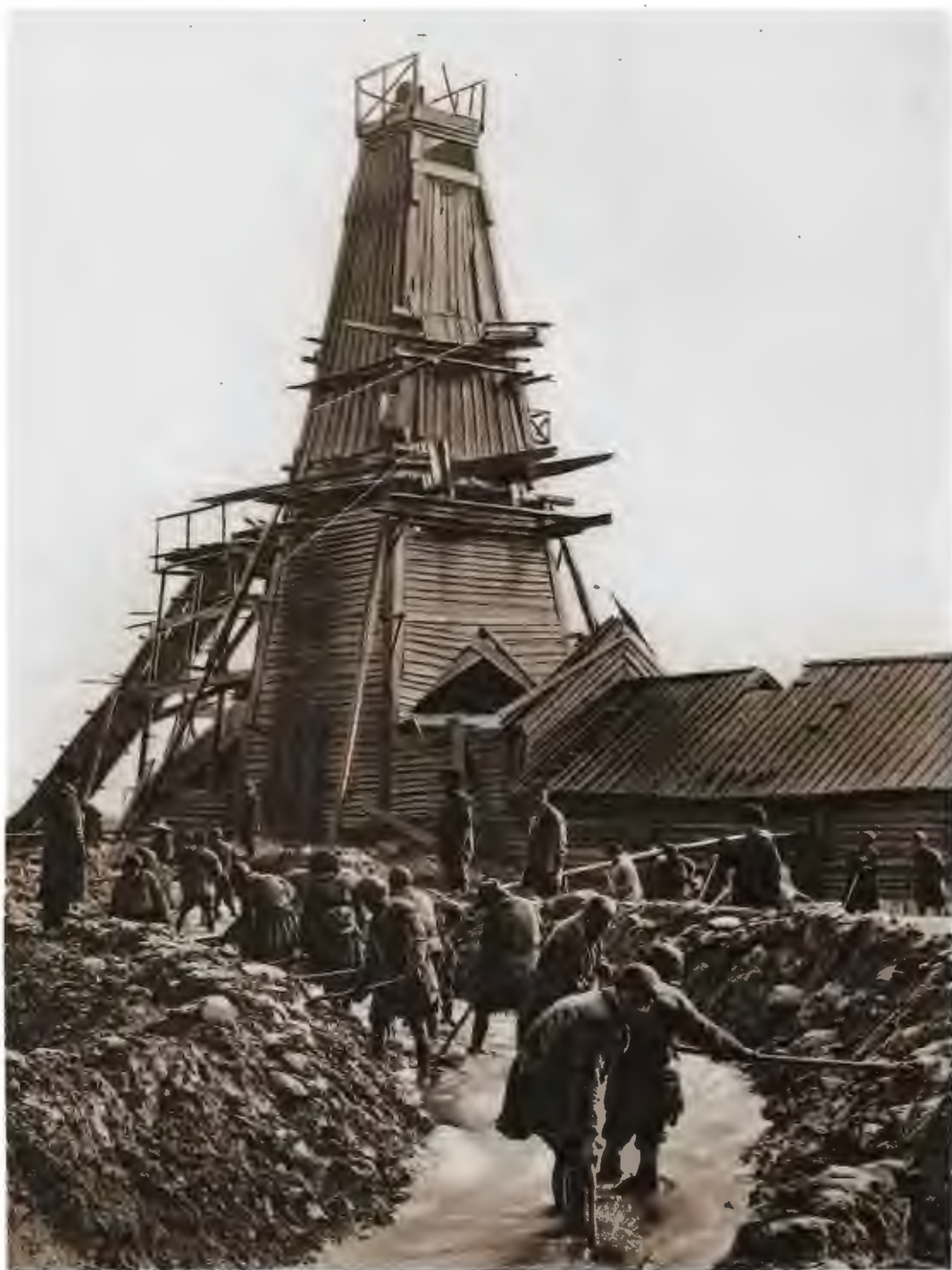
Земляныя работы у фонтанирующей скважины.
