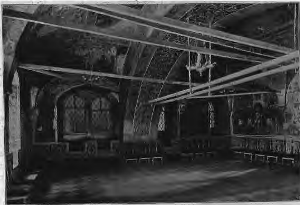
Рис. 256. Золотая царицына палата, построенная при царѣ Федорѣ Ивановичѣ, въ ея современномъ видѣ, съ желѣзными связями и каменными перететивьями, устроенными въ 1683 году для укрѣпленія ея сводовъ. Южная сторона.
