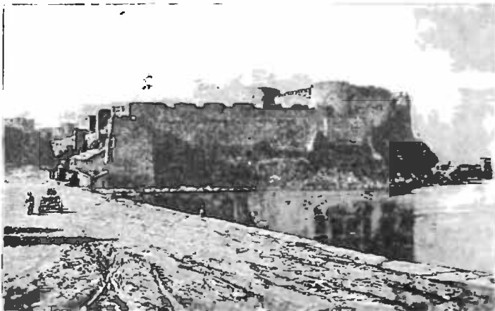
166. Бѣлгородъ (теперь Аккерманъ).
