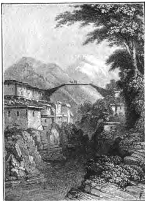
Мостъ черезъ рѣку Ахты-Чай.
