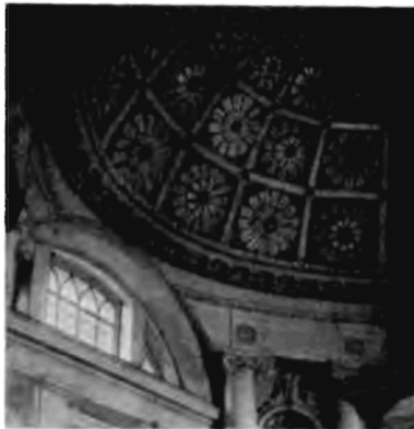
„Покровское“. Куполъ (кессончатый) церкви.
