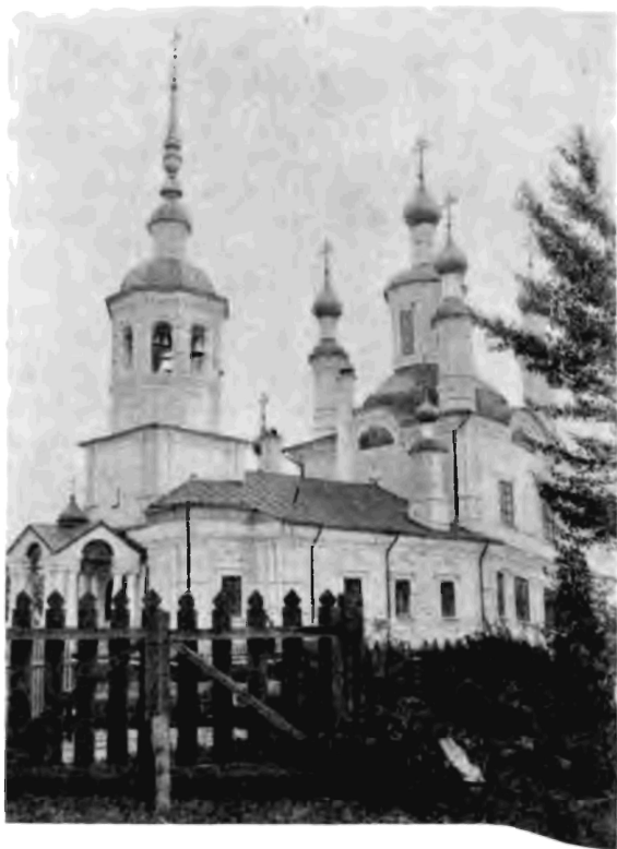
Церковь Спаса на Болотѣ.
