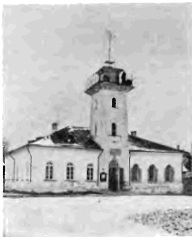
Зданіе II полиц. части (1853 г.).
