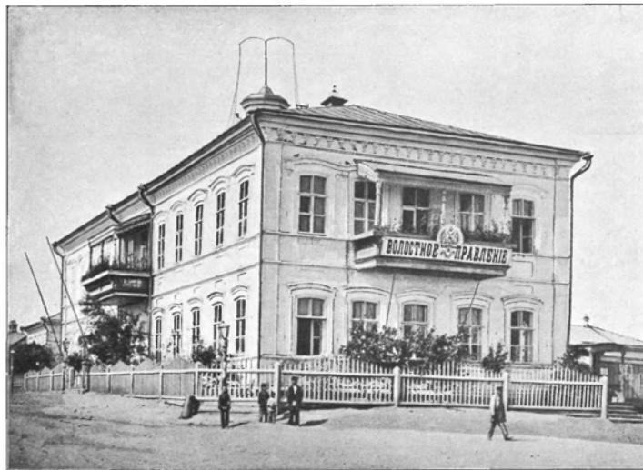
Слов. Николаевская, Царевскаго уѣзда, Астраханской губ. Домъ волостного правленія. Сооруженъ сельскимъ обществомъ въ 1893 году.
