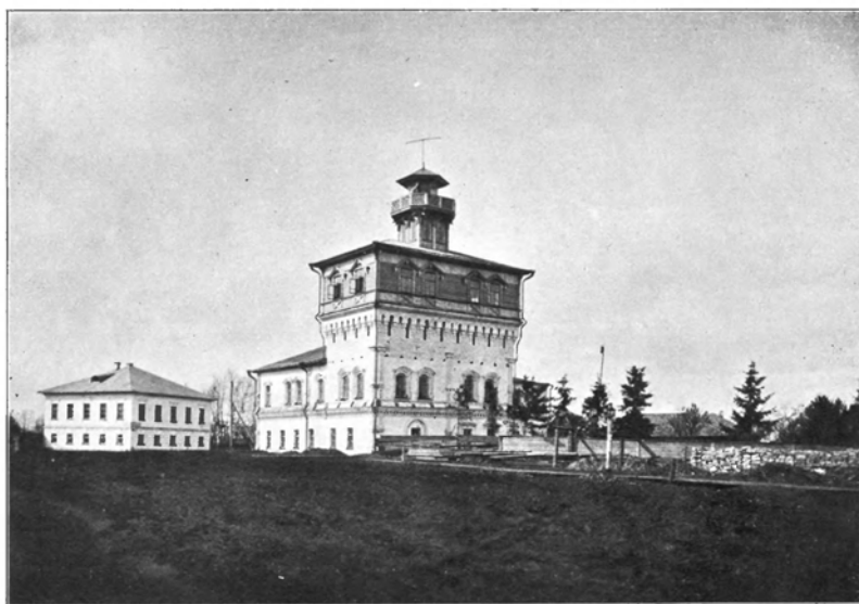
Гор. Вятка. Водоподъемная башня городского водопровода. Перестроена въ 1900 г. изъ стариннаго ссруженія, извѣстнаго по плану 1787 года подъ именемъ «старыхъ каменныхъ палатъ купца Толмачева». Въ этомъ зданіи въ 1860 г. помѣщалась городская богадѣльня.
