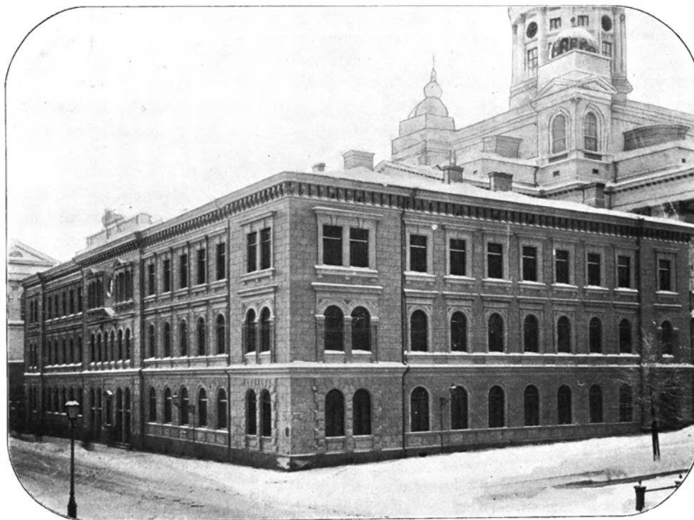
Зданіе Гельсингфорской Почтовой Конторы.
