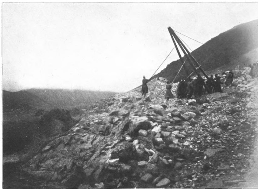
Установка тройнаго телеграфнаго столба въ гористыхъ мѣстахъ Туркестанскаго края.
