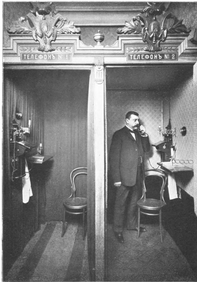
Переговорный кабинетъ телефонной линіи Петербургъ—Москва.
