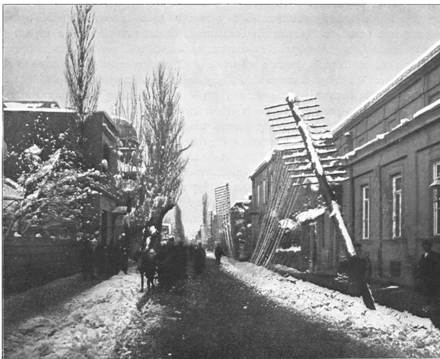
Разрушеніе телефонной линіи въ Одессѣ въ 1897 году.
